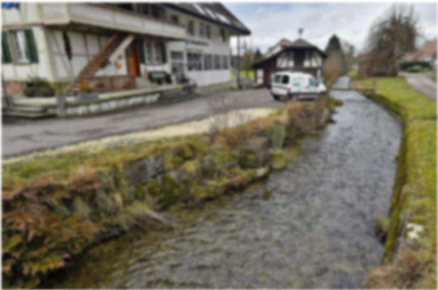
Ende Mai könnte es langgehen. Die Ösch soll auf einer Länge von etwa 400 Metern zu einem Kanal umgebaut werden, das die hohe künftige Überspannungen trägt.
